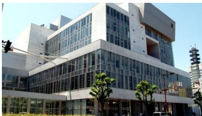
②長野市役所新第一庁舎
